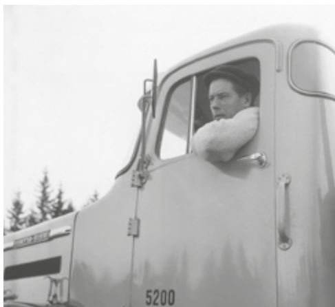
Rakentaja-lehden 9/61 mukaan "3,5 miljoonan markan työkalu on tällä miehellä, joka kuljettaa soraa ratatyömaan pengerryksille." Kuva: Rakennusliitto.
